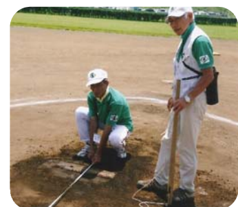
ピッチャープレート設置 投球間距離点検 作業風景
